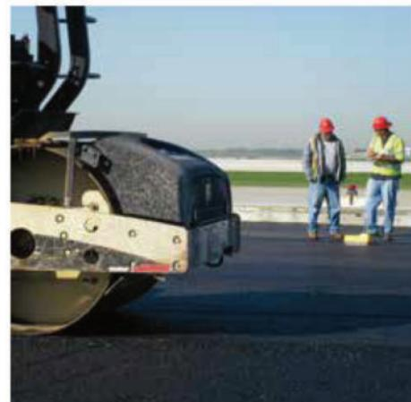
Вимірювання щільності проводяться на покритті, вкладеному за технологією із застосуванням Rediset® LQ на проекті модернізації аеропорту О'Хара.
