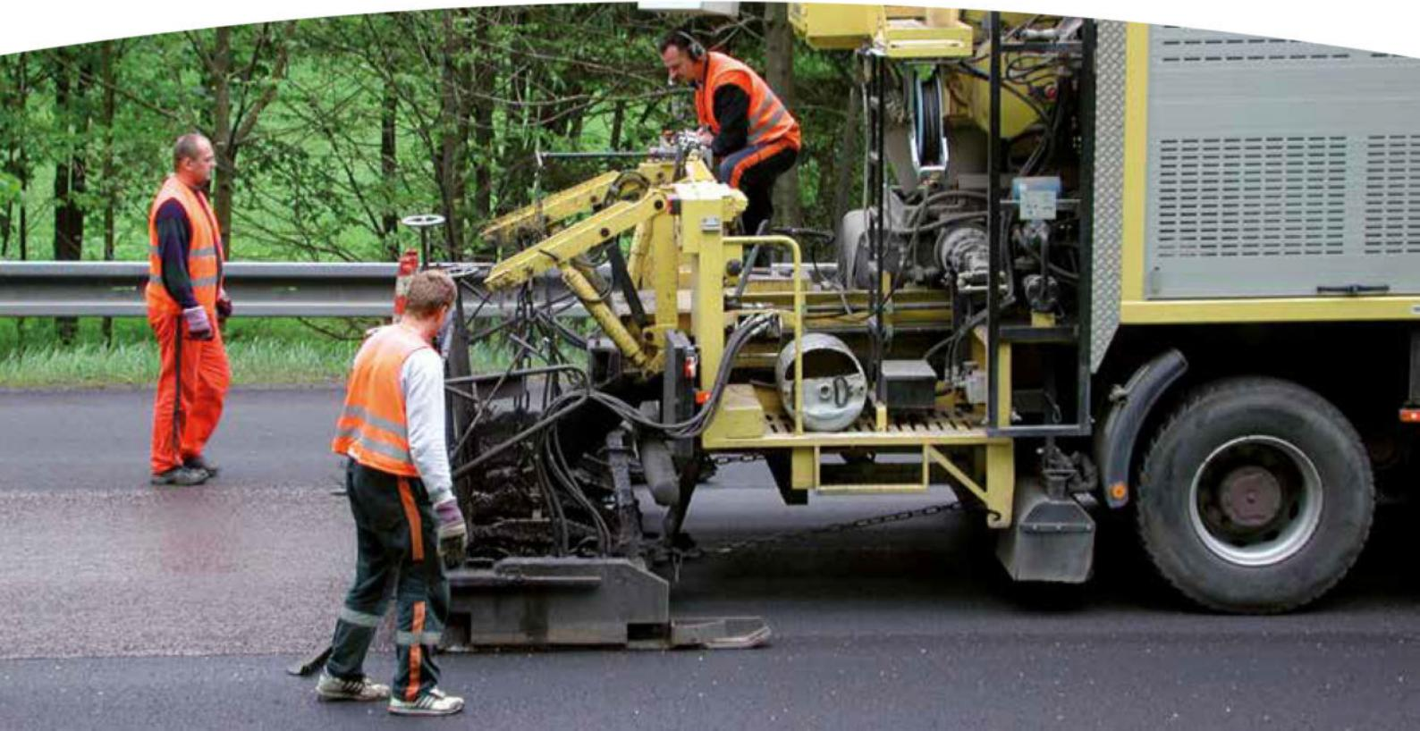
простого обладнання. При проведенні холодного ресайклінгу застосовуються бітумні емульсії або самі по собі, або в поєднанні з цементом чи вапном. Зазвичай використовуються емульсії повільного розпаду.
