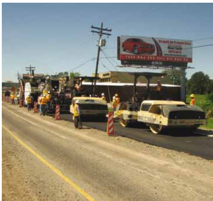
Отличное уплотнение щебеночно-мастичных асфальтобетонных смесей (ЩМА) в Бомонте, Техас, США
